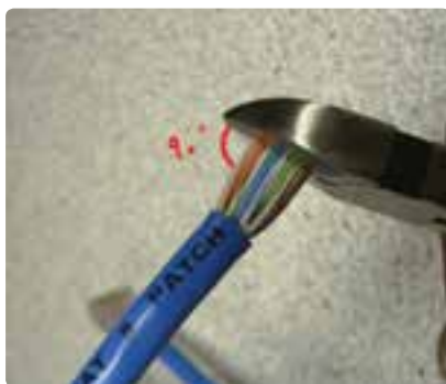
شکل ۴۵-۴- برش سیم‌های کابل شبکه
